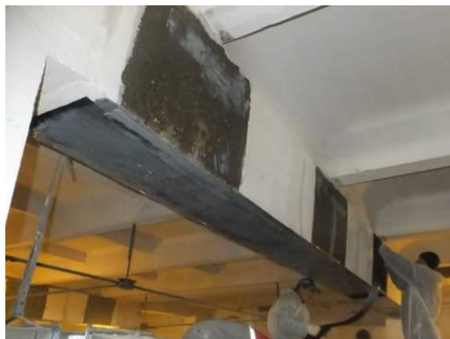
Усиление балок Башня промывки фильтров. Рублевская станция водоподготовки ОАО «Мосводоканал»
