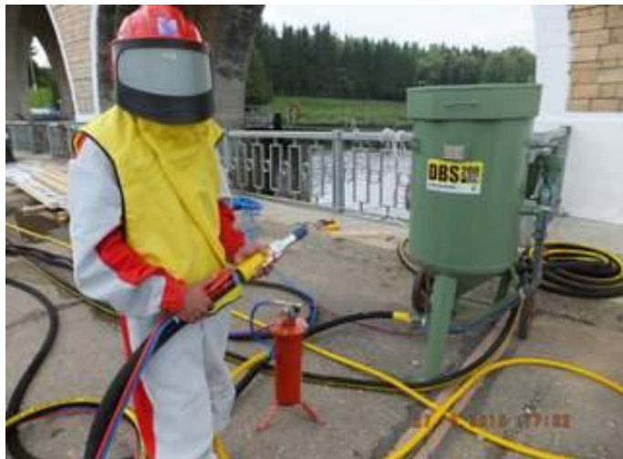
Пескоструйная обработка
