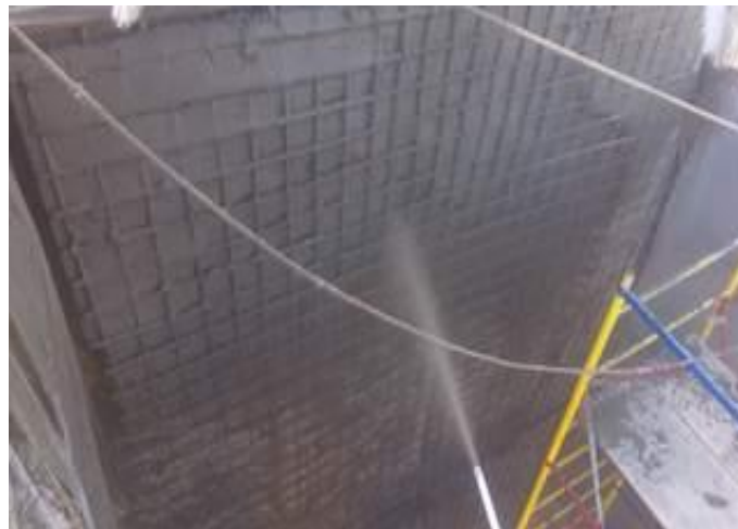
«Торкретирование» набрызг бетона
